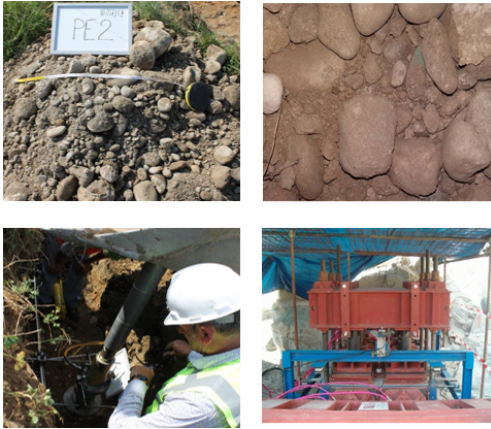
Figure 1. Area di scavo in terreno vergine e pozzetti esplorativi e lo studio dei sottofondi strutturali per aree di stoccaggio materiali.
