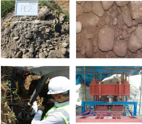
Figure 1. Area di scavo in terreno vergine e pozzetti esplorativi e lo studio dei sottofondi strutturali per aree di stoccaggio materiali.
